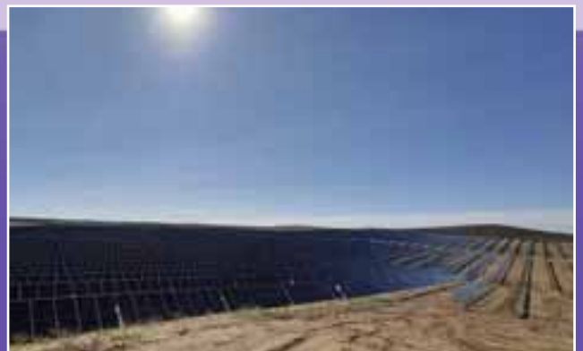
Construcción Plantas Fotovoltaicas en Toledo: "Ictio Toledo Solar", 50 MW & "Ictio Ahín Solar", 15 MW.
