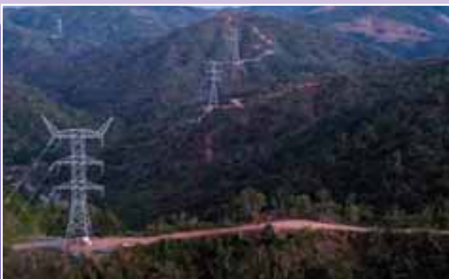
Reconstrucción Línea (400 kV) Acapulco por efectos del Huracán Otis. México.
